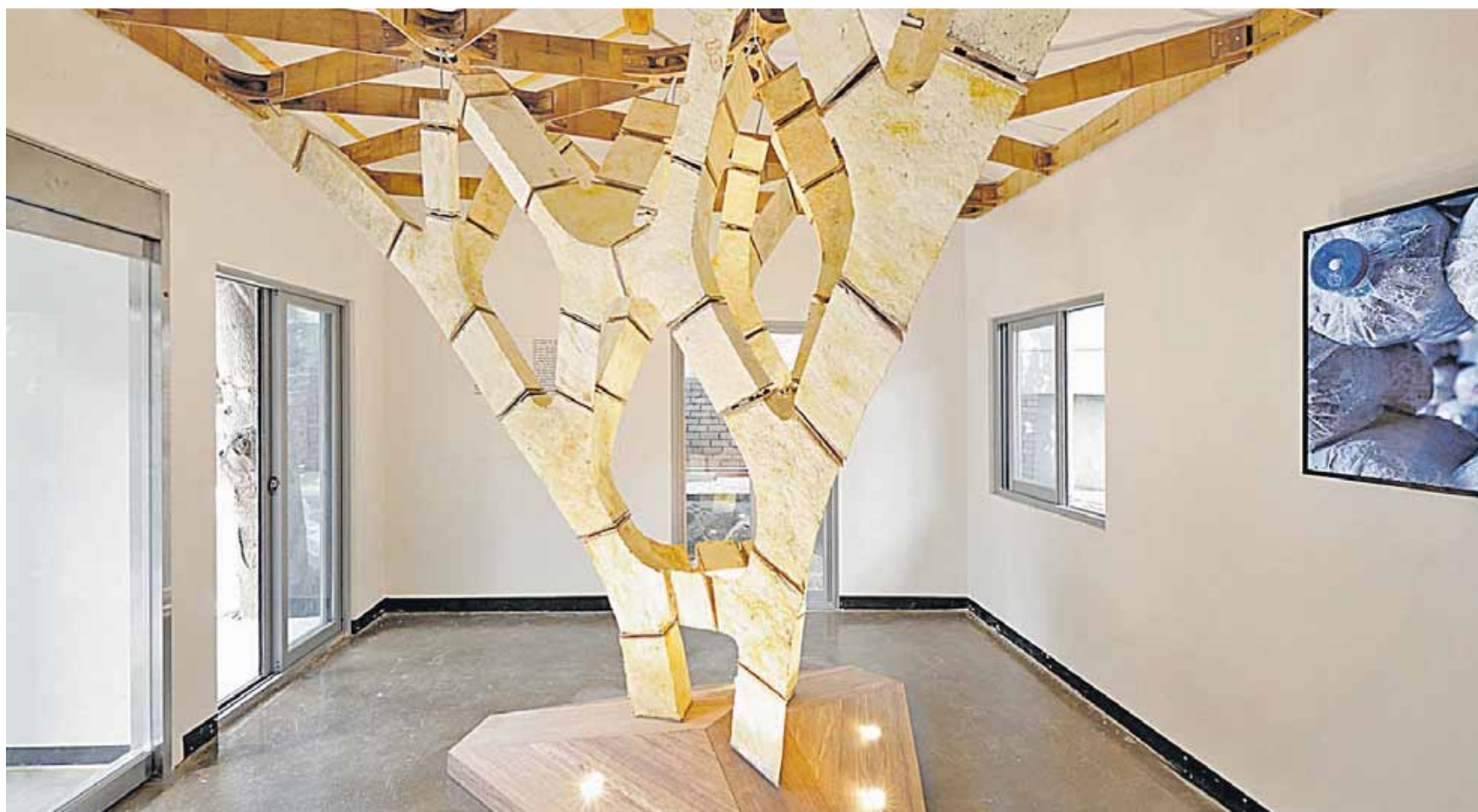
Architektonische Visionen: Der „Mycotree“ wurde 2017 bei der Seoul Biennale of Architecture and Urbanism gezeigt (großes Foto). Er besteht aus Pilzmyzelium und Bambus und hat eine selbsttragende Struktur. Solche Bausteine entstehen, indem Pilzsporen mit Holzspänen oder anderen pflanzlichen Abfällen gemischt werden (kleines Foto links). In wenigen Tagen wächst eine dichte Substanz aus Zellfäden heran; die Masse lässt sich in fast jede Form füllen (Foto rechts). Wissenschaftler hoffen, dass damit künftig sogar Häuser errichtet werden können. FOTOS: MYCOTREE, ECOVATIVEDESIGN.COM (2)
